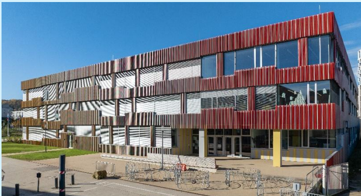
Vor- und Grundschule Differdange
